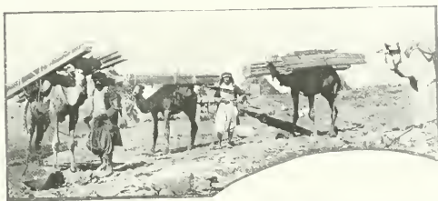
TRANSPORT DE MATÉRIEL POUR LA CONSTRUCTION D'UNE ÉCOLE
